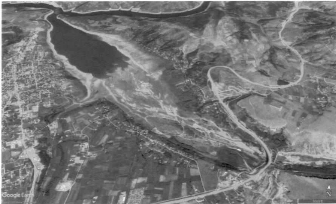
Figura 24 - Zona e prekur nga përmbytjet dhe erozioni në fshatrat Lume dhe Përbreg
